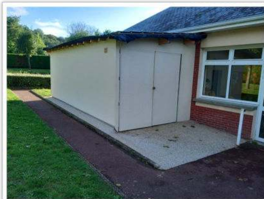
Aménagement extérieur du container
